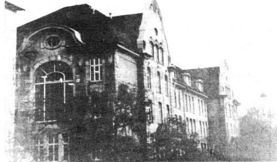
Edificio que ocupa el Instituto de Química de la Universidad de Zurich.
